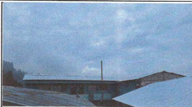
Foto1: Finalizacion de techo aula 1 y 2
