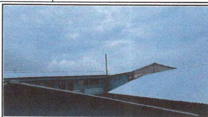
Foto 2: Finalizacion de techo aula 3 y 4
