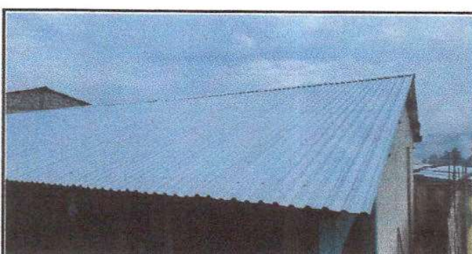
Foto 6: Finalizacion de techo aula 5 y 6 y Direccion
