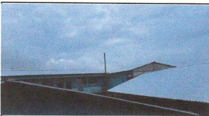
Foto 3: Finalizacion de techo aula 1 y 2
